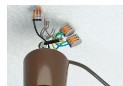
Conexión de elemento de iluminación con conductores flexibles y alimentación de corriente
